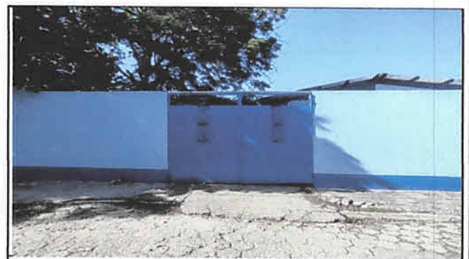
Reparación y mantenimiento de portón principal.
