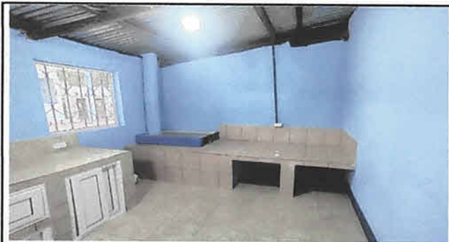
Reparación de Mesón, colocación de azulejo y piso.
