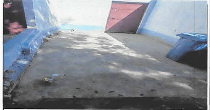
Reparación de torta de concreto y traslado de depósito de agua.
