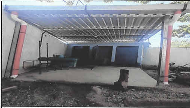
Galera e instalación de sistema eléctrico en galera.
